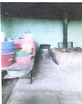
Foto 3: Mejoramiento de piso de concreto
