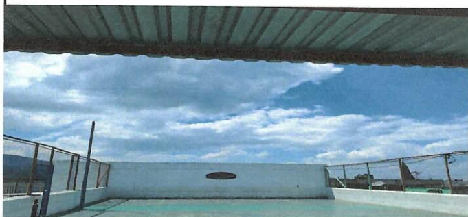
Foto 1: MEJORAMIENTO DE AREA DE PATIO CON CUBIERTA
