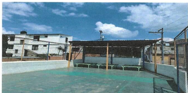
Foto 3: MEJORAMIENTO DE AREA DE PATIO CON CUBIERTA.
