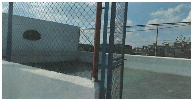
Foto 5: MEJORAMIENTO DE ARA DE PATIO CON CUBIERTA
