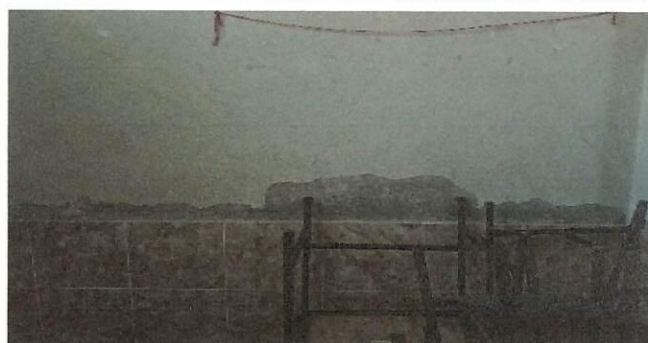
Foto 4: MANTENIMIENTO PAREDES DE COCINA
