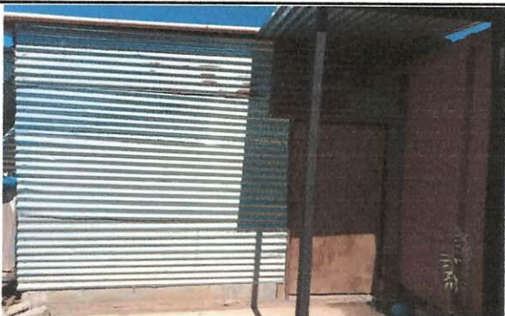
Foto 3: Seguidamente observamos la bodega, realizado en su totalidad de lámina, con una puerta de madera, en la cual se resguarda diferentes materiales.
