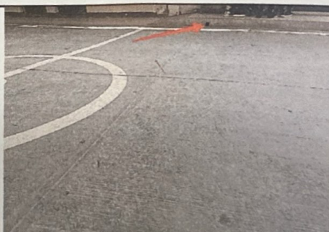
Foto 6: En la fotografía se observa que el tubo de bajada de agua pluvial da hacia el patio de la escuela lo que provoca inundaciones en el área.
