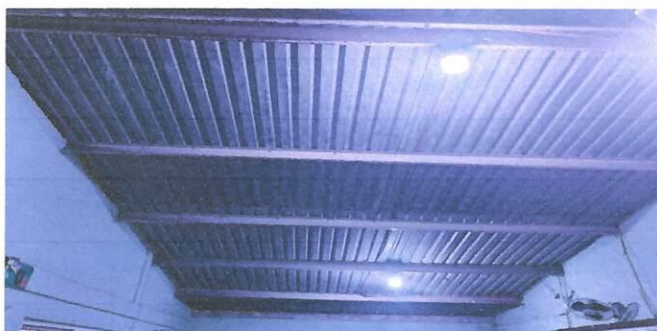
FOTO 5 SUSTITUCIÓN DE LÁMINA DE TECHO POR LÁMINA TERMO ACUSTICA AULA 1ERO A
