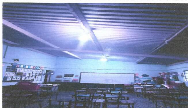
Foto 2: SUSTITUCIÓN DE LÁMINA DE TECHO POR LÁMINA TERMO ACUSTICA AULA 1ERO B
