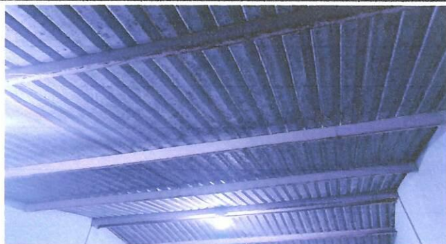
Foto 3: SUSTITUCIÓN DE LÁMINA DE TECHO POR LÁMINA TERMO ACUSTICA AULA 1ERO A
