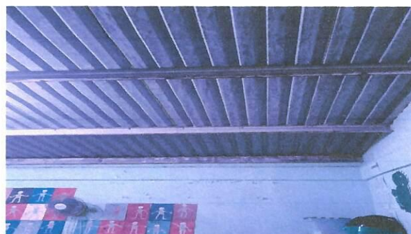
Foto 4: SUSTITUCIÓN DE LÁMINA DE TECHO POR LÁMINA TERMO ACUSTICA AULA 1ERO B
