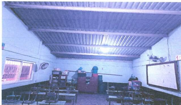
Foto1: SUSTITUCIÓN DE LÁMINA DE TECHO POR LÁMINA TERMO ACUSTICA AULA 1ERO A
