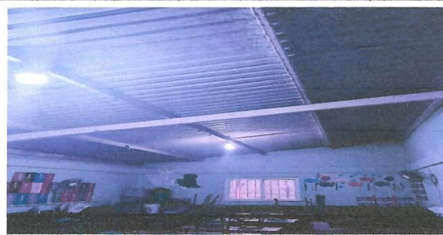
Foto 6: SUSTITUCIÓN DE LÁMINA DE TECHO POR LÁMINA TERMO ACUSTICA AULA 1ERO B
