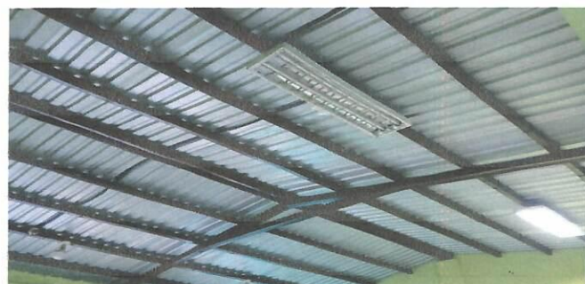
Foto 6: Lamparas en las aulas segundo nivel
