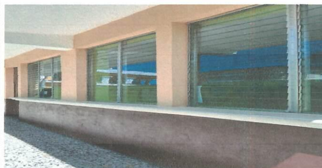
Foto 4: Balcon segundo nivel
