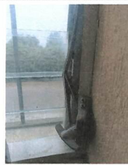
Foto 6: En la fotografía se observa que la perilla para abrir la ventana está quebrada, la estructura deformada y los vidrios hacia la calle han quedado abiertos y no es posible cerrarlos.
