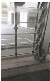
Foto 5: Se observa la estructura de aluminio que se ha deformado dejando las ventanas abiertas sin posibilidad de cerrarlas.
