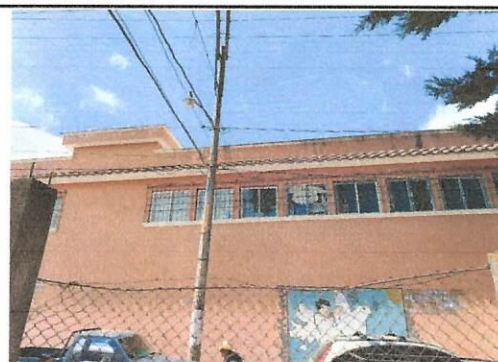
Foto 6: Pintura exterior de escuela
