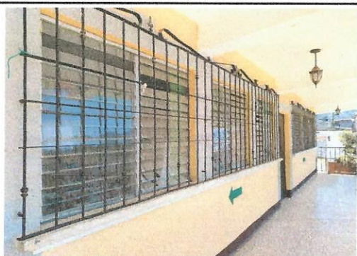
Foto 5: Sustitución de ventanas a ventanas de PVC de aulas
