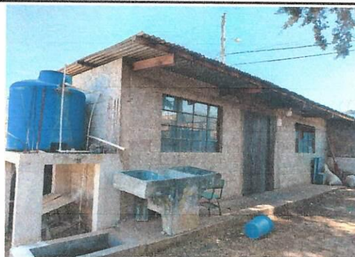
Foto 2: Repello paredes exterior de cocina y cambio de ventanas a PVC
