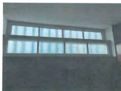
Foto 4: MODIFICACIÓN DE VENTANA CORREDIZA CON MOSQUITERO
