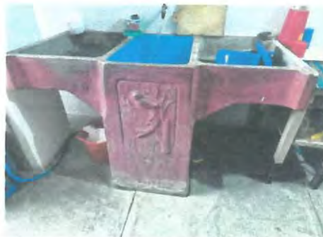
CAMBIO DE PILA E INSTALACIÓN DE CHORRO
