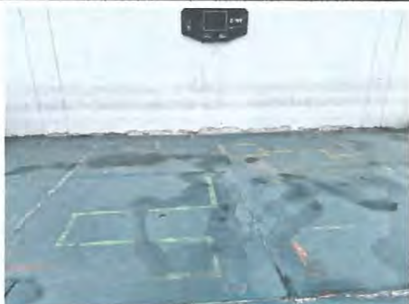
Foto No. 12 Tallado de zocalo, en grietas, area de la terraza
