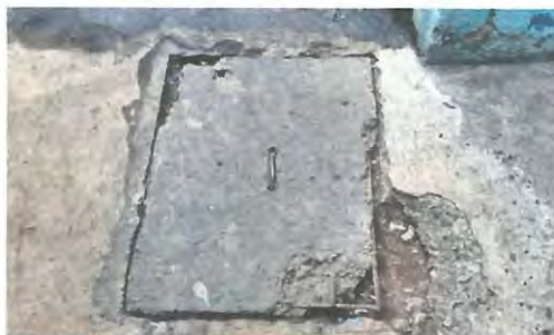
Foto No. 13 Sustitución de tapadera de cemento.
