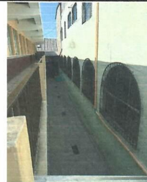
Foto 2: foto desde arriba lado izquierdo (Ampliacion techo)
