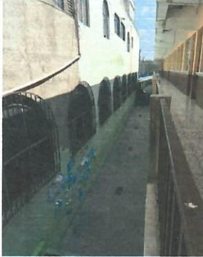
Foto1: foto desde arriba lado derecho (Ampliacion techo)
