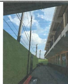
Foto 6: foto desde abajo (Ampliacion techo)
