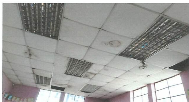
Foto 3: Cambio de cielo falso y cambio de alumbrado
