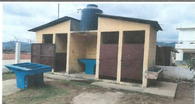
Foto 5: Mantenimiento de puertas de sanitarios.
