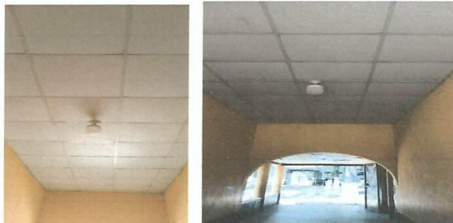
Foto 6: Cambio de focos de varios puntos del centro educativo
