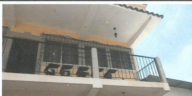
Foto 6: remozamiento de baranda del segundo nivel.
