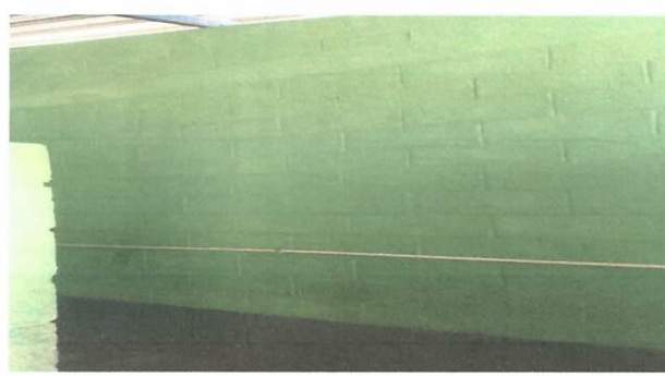
Foto 2: colocación de azulejo en todo el área de los sanitarios.
