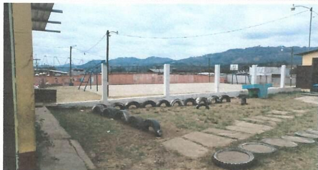
Foto 1: cuidando la integridad de los alumnos, se necesita mejorar el muro perimetral
