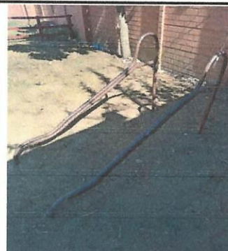
Foto 2: Reparación de resbaladero, las bases se encuentran aun en condiciones para ser reutilizado.
