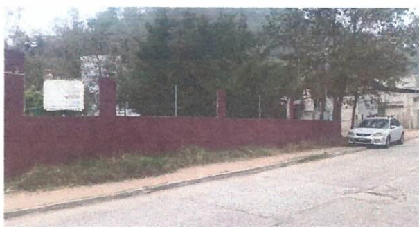
Foto 3: fotografía de la parte frontal externa del establecimiento, aqui se hara el levantado de muro perimetral, ya cuenta con el 50% de levantado de pared esta representa la parte del frente del establecimiento.
