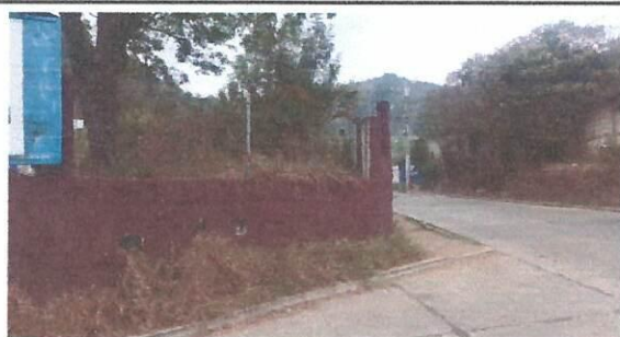
Foto 5: fotografía del muro perimetral del lado de salida de emergencia externa. Esta imagen muestra el muro perimetral de la salida de emergencia y el levantado del mismo que se encuentra al 50%.
