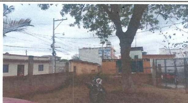
Foto 6: fotografía del muro perimetral del lado de salida de emergencia interna. y su estado actual.
