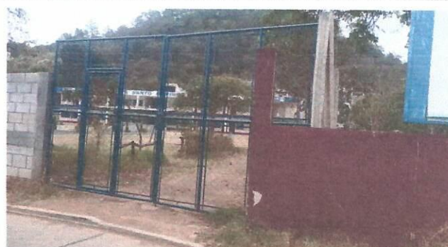
Foto 2: fotografía de salida de emergencia del lado derecho del establecimiento externo. Esta imagen muestra el porton de la salida de emergencia de medidas 5 metros de ancho por 2 metros y ochenta cm de
