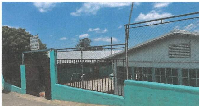
Foto 3: vista area continuidad de levantado de muro pineado.
