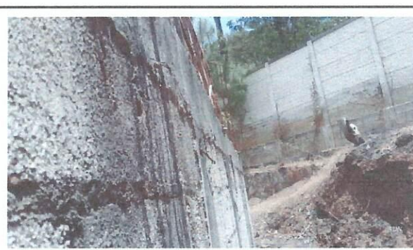
DIR Foto 6: COLOCACION DE PESTAÑA DE LADRILLO
