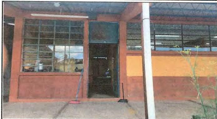
Foto1: Entrada de cocina a ser remodelada los arreglos solo la parte de adentro
