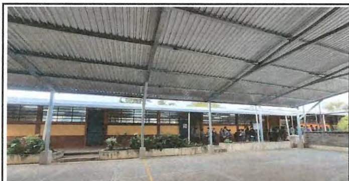
Cooredor a cubrirse de tubo galvanizado y elctromalla cancha pequeña con techo para cubrir ventanas y proteger a los niños pequeños del juego de pelota
