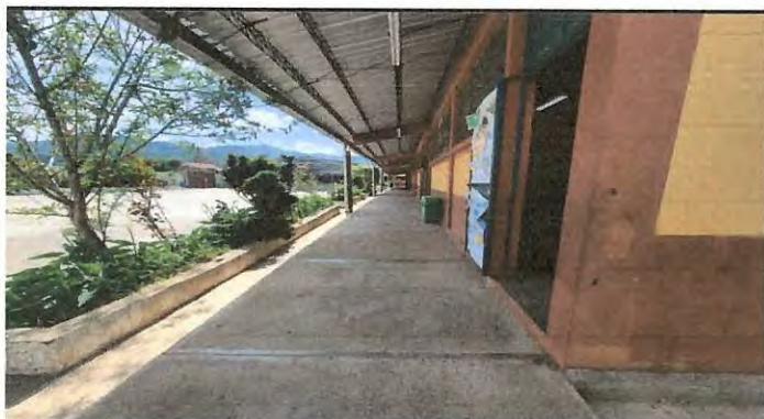
Vista del corredor a cubrir con electromalla fundido en el piso
