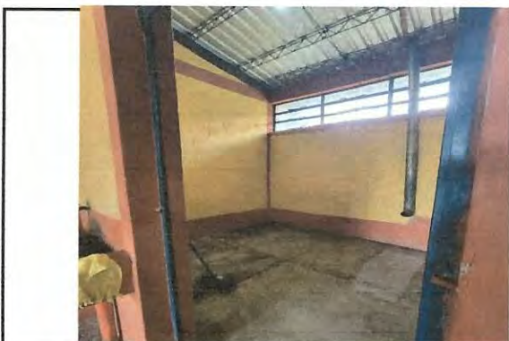
Espacio donde sera construida la estufa de ladrillo de cuatro hornillas y chimenea de concreto
