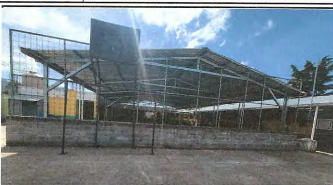
Pared que divide las dos canchas deportivas desde otro ángulo
