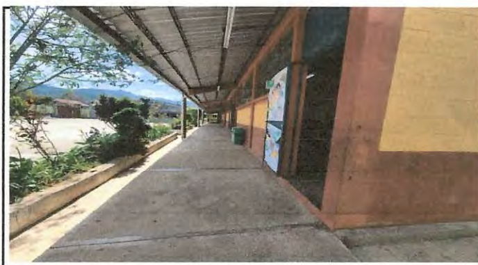
coordor desde otro angulo dinde sera cubierto de electromalla siendo un total de 52 metros de largo y 3 metros de alto.
