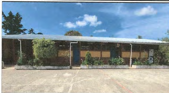
Area donde se instala tubos galvanizados y electromalla para proteger a los puequeños de los pelotazos que vien e de la cancha asi mismo de cuidr las ventanas de vidrio.
