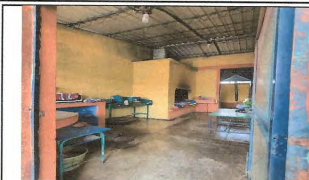
Parte de la cocina a ser demolida parte donde se construye una pila de concreto
