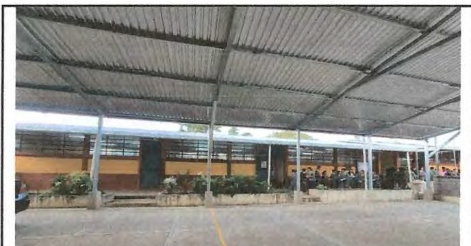
Vista desde otro angulo parte a ser cubierta con electromalla
