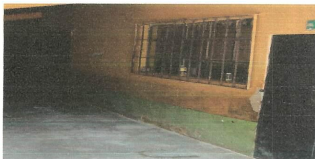
Foto 6: Mantenimiento y pintura.
