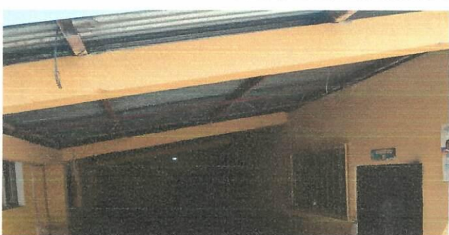
Foto 3: Mantenimiento e instalación de electricidad.
