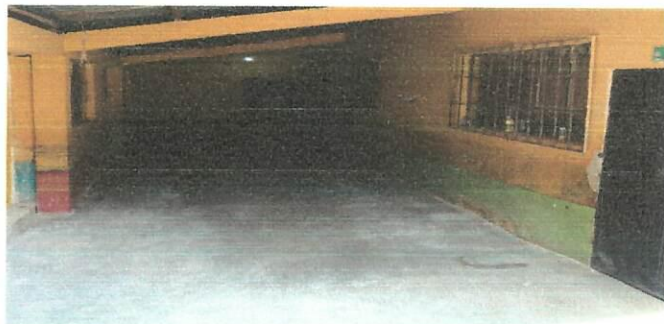
Foto1: Suministro y colocación de piso.
