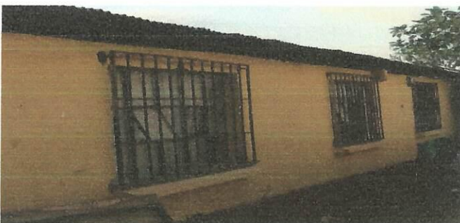
Foto 5: Mantenimiento y pintura de balcones.
