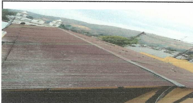
Foto 2: Remozamiento de techo existente en salones.
