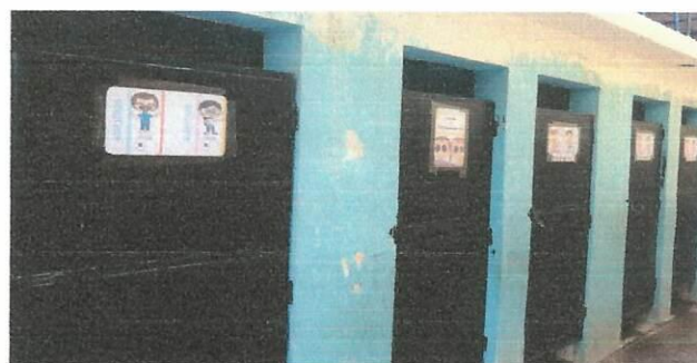
Foto 4: Mantenimiento y pintura de baños.
