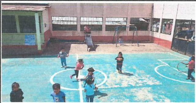
Foto1: MEJORAMIENTO TECHADO ÁREA DE PATIO
