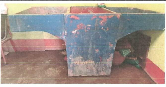
Foto 4: MEJORAMIENTO DE PILA
