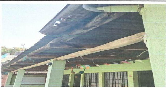
Foto 2: MEJORAMIENTO TECHADO ÁREA DE CORREDOR
