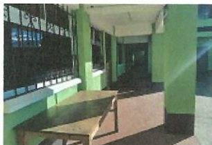
Foto1: MANTENIMIENTO DE PINTURA CIELO SALÓN DE CLASES
