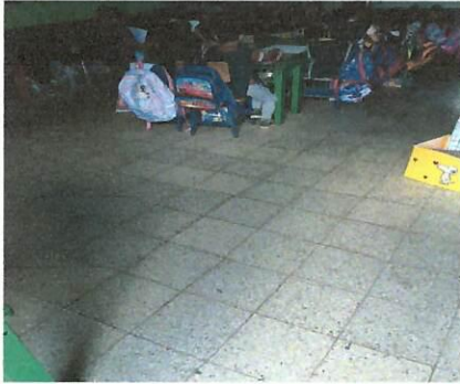
Foto 1: SUSTITUCIÓN DE PISO SALÓN DE CLASES
