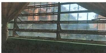
Foto 3: sustitución por ventanas corredizas
