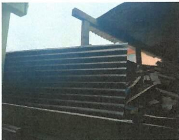
Foto 5: SUSTITUCIÓN DE CERCO
