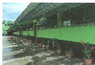
Foto 2: INSTALACIÓN DE CAIDAS DE AGUA
