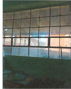
Foto 2: MEJORAMIENTO DE VENTANALES DE LOS SALONES DE CLASE Y COCINA
