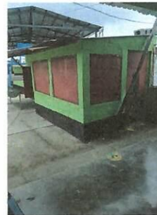
Foto 4: SUSTITUCIÓN VENTANAS DE LA TIENDA ESCOLAR
