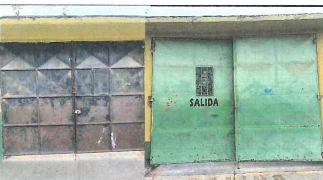
Foto 4: Reparación de porton de entrada vehicular
