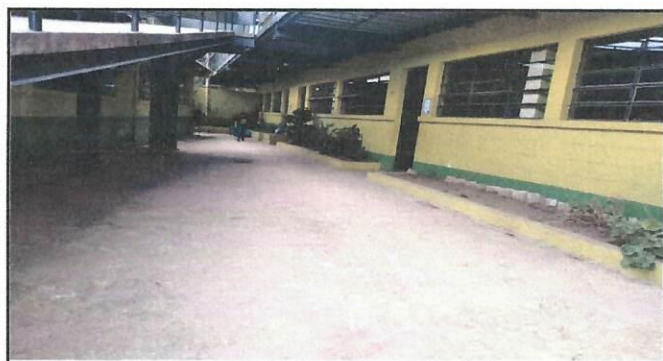
Foto 3: Reparación del piso de concreto
