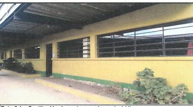
Foto 5.1 : Sustrucción de ventanas primer nivel (4)
