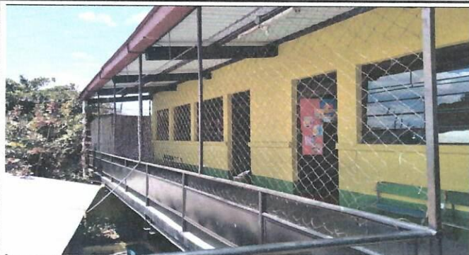
Foto1: Sustrucción de malla y lámina
