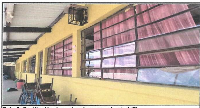
Foto 5: Sustrucción de ventanales segundo nivel (7)
