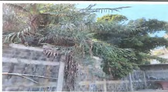
Foto 10: Muro de contención que será pintado en su totalidad para darle mejor vista.
