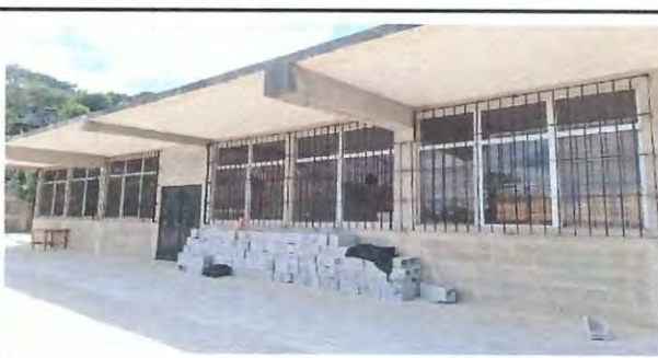
Foto 6: Área que será intervenida para la pintura de la parte exterior de los salones.
