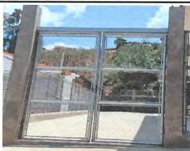
Foto 17: Se sustituirá el portón de malla de la entrada y se instalará uno de metal con chapa.
