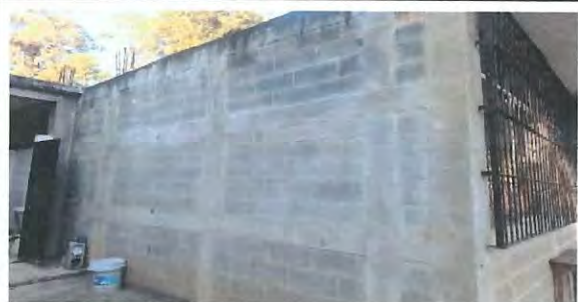
Foto 9: Área Lateral exterior de los salones que sera pintada en su totalidad.
