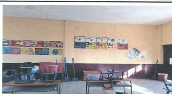
Foto 14: En la parte interior y exterior de los salones también serán pintadas las paredes.
