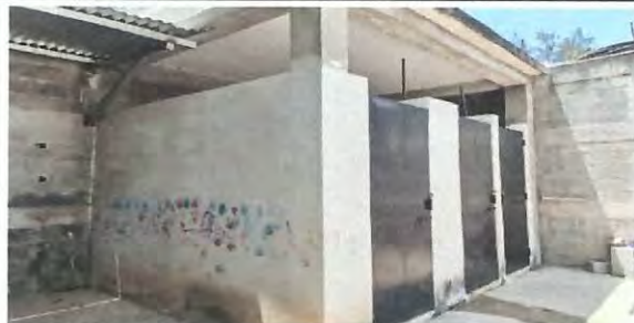
Foto 12: Los Sanitarios también serán pintados en su totalidad tanto en el interior como en el exterior.
