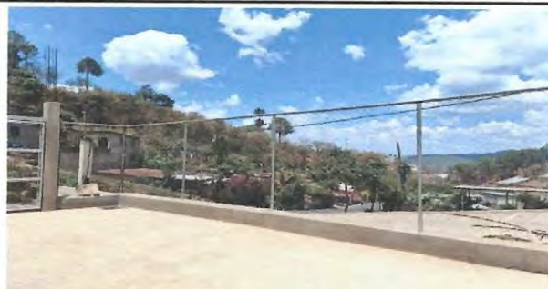
Foto 4: Después de mejorar el muro perimetral (muro Prefabricado) se contempla pintar el interior y exterior de las paredes.
