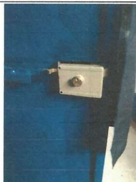
Cambio de dos chapas.
