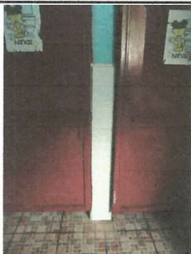
Colcación de azulejo faltante en área de baños.
