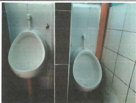
Colocación de mingitorios.
