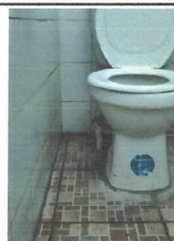
Levantado y revisión de sanitario por fuga en tubería.
