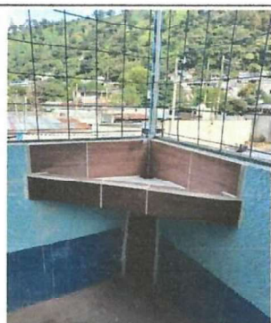
Fundición de un lavadero forrado de azulejo
