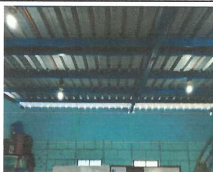
Nivelación de techo.
