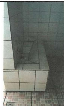
Mejoramiento y Colocación de mingitorios.
