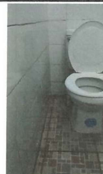
Levantado y revisión de sanitario por fuga en tubería.
