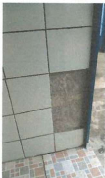
Colcación de azulejo faltante en área de baños.
