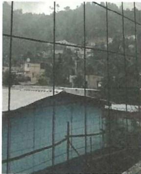
Techado de estructura metálica y cambio de doble agua a una línea.
