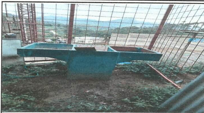
Foto 8: construcción de pila techada para el area de cocina.
