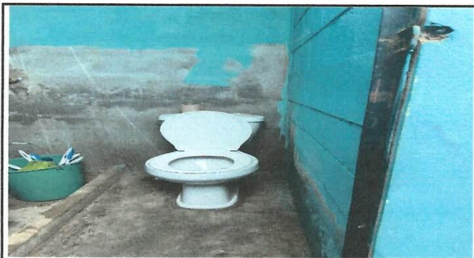
Foto 3: Sustitución de piso en servicios sanitarios, cambio de taza de baño, colocación de lavamanos y azulejo.
