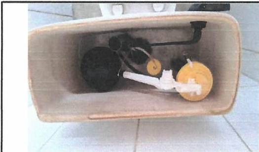
Foto 17: Se sustituirá el juego de la bomba del tanque del sanitario de sexto "A".
