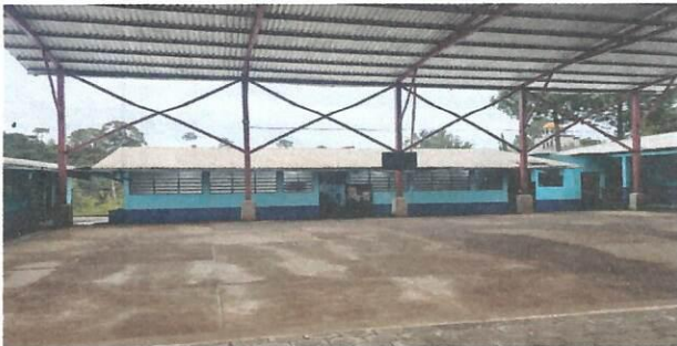
Foto 10: 63 metros de circulacion de cancha deportiva multiple estructurado con tubos de 2*2 chapa de 18 galvanizados y reforzados y circulos con electromaya de 4.5*4.5 de espesor.
