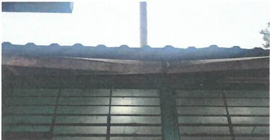
Foto 9: Metros de canal reforzado con pescantes elaborados de angular de 1*1/8 de espesor.
