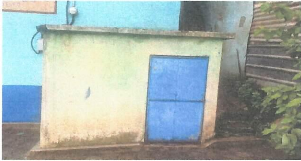
Foro 12. Reemplazo de puerta grande
