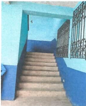
Foto 6: Elaboracion e instalacion de puerta tipo reja de 1.52 mts. de ancho por 2.70 mts. Altura de tipo dos hojas color negro.
