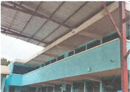
Foto 5: 35 metros de estructura con tubos de 2*2 chapa 18 galvanizado en segundo nivel y reforzado, circulado con electromaya de 4.5*4.5 de espesor
