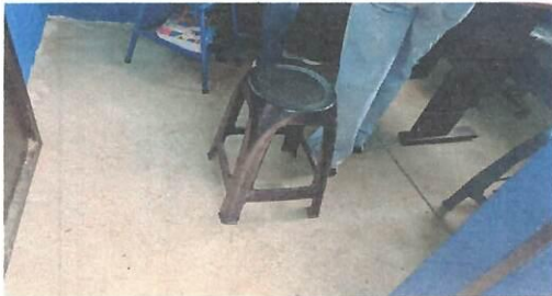
Foto 8: Instalación de piso ceramico en Dirección.
