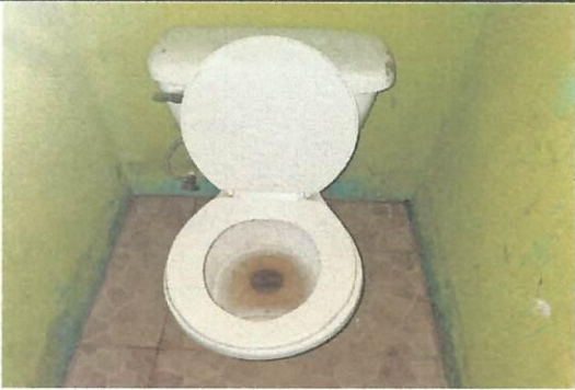
Foto1: instalacion de tuberia de drenaje de 80 PSI 4", instalacion de tuberia de 100 PSI 3", instalacion de tuberia de 2", instalacion de tuberia de agua potable de 1/2, cambio e instalacion de sanitarios. Demolicion y
