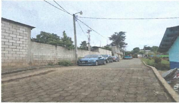
Foto 11. Construcción de dos columnas de 30*30 cm. Construcción de muro de block de 15*20*40
