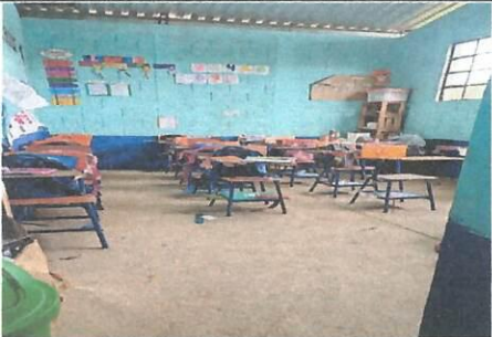
Foto 7: Instalación de piso ceramico en salon de clases
