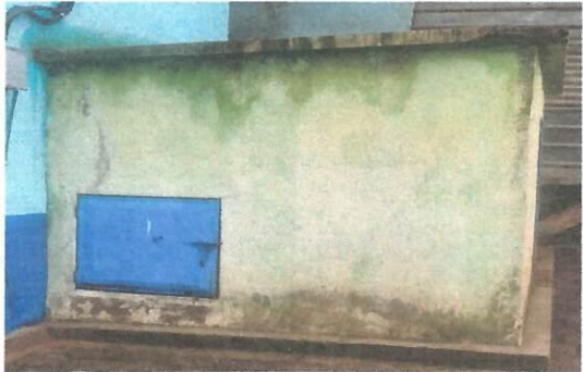
Foto 13. Reemplazo de puerta pequeña
