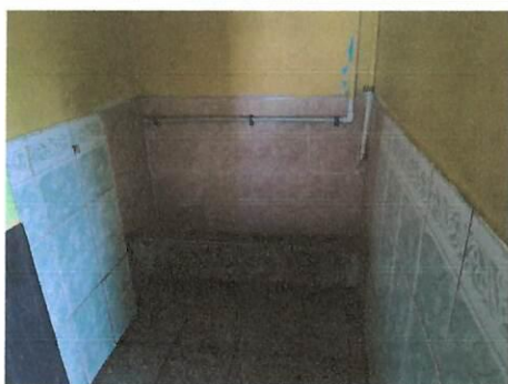
Foto 5: Sustitución de azulejo 4 sanitarios
