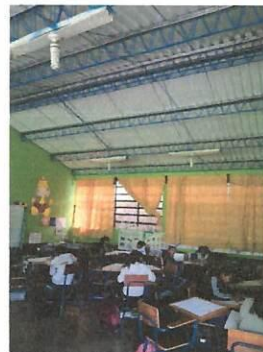
Foto 2: Mantenimiento de iluminación salones de clase (INDICAR GRADOS) Y NIVEL- PRIMARIA
