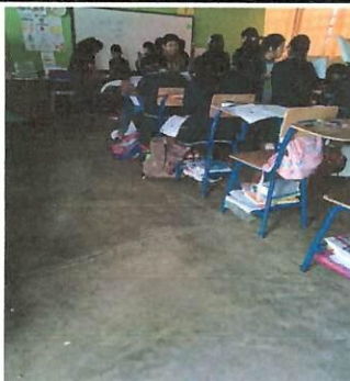
Foto1 Sustitucion de piso a 4 salones de clase DEL NIVEL PRIMARIO
