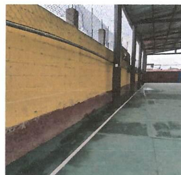
Foto 4: mantenimiento y colocación de maya área faltante
