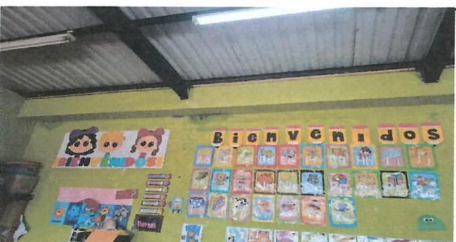
Foto 12: Mantenimiento de canal interno del segundo nivel, párvulos.
