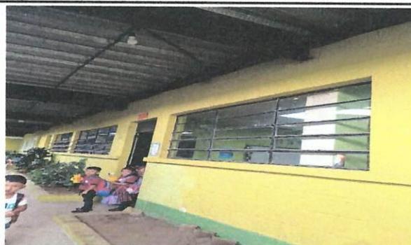
Foto 14: Sustitución de tres ventanas, párvulos.
