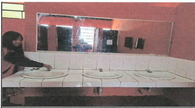
Foto 3: Sustitución de la base de lavamanos de sanitario de niñas.
