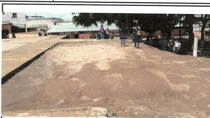
Foto 2: Reparación de loza
