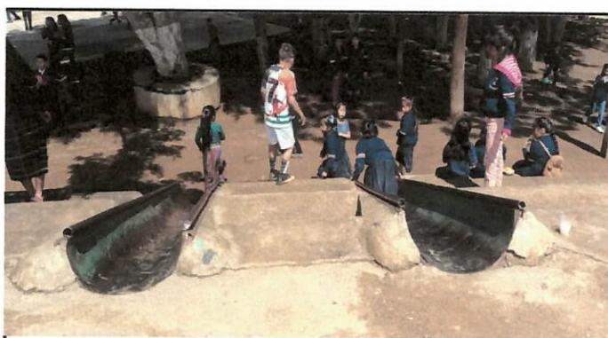
Foto 4: Reparación de resbaladeros.
