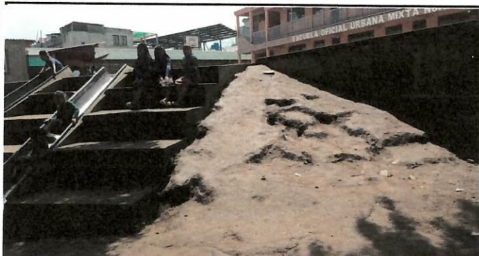
Foto 3: Continuación y reparación de graderio de parque infantil escolar
