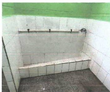
Foto 5: Las llaves y azulejos de los migratorios no se encuentran en buen estado y generan mal olor.
