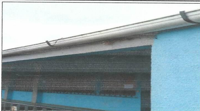
Foto1: Ampliación de pestaña del techo.
