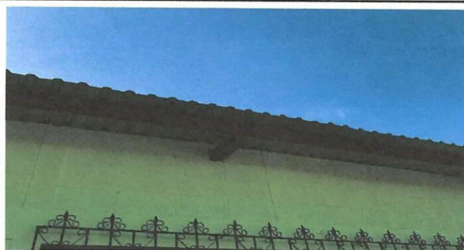
Foto1: las costaneras fueropn lijadas y pintadas para su instalacion
