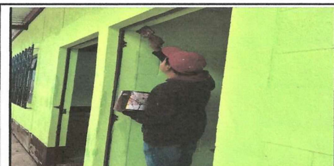
Foto 6: las puertas son retiradas ya que necesitan ser lijadas y pintadas nuevamente
