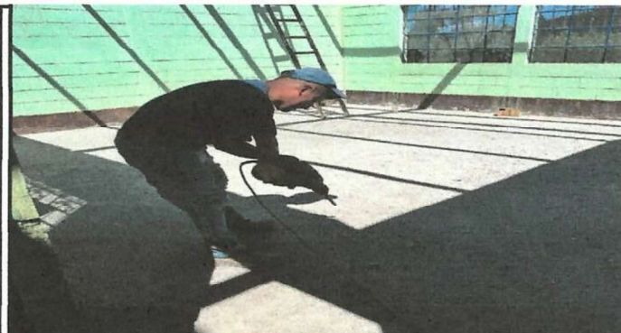
Foto 4: la torta es picada para poder realizar el cambio a piso cerámico
