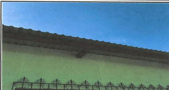
Foto 1: las costaneras son lijadas y pintadas
