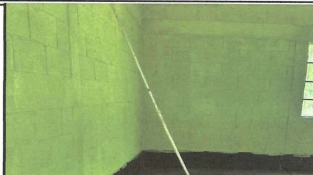
Foto 2: las paredes del establecimiento son pintadas para que tenga otro aspecto
