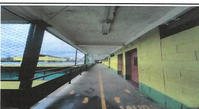
Foto 4: Corridor trasero, segundo nivel y esta previsto para colocar iluminación
