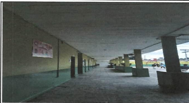
Foto1: patio frontal,previsto a colocación de iluminación.
