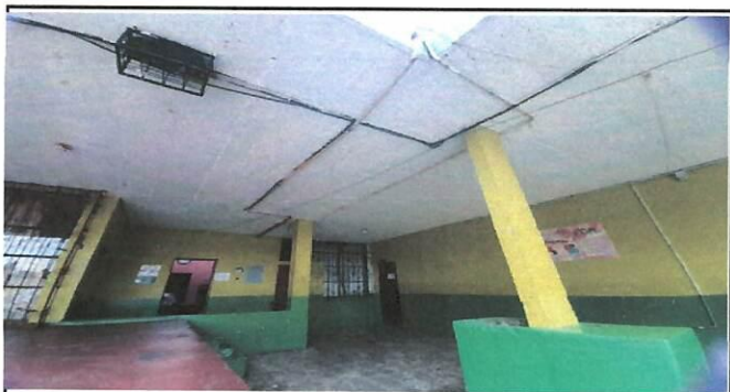
Foto 7: corredor frontal ,previsto a colocación de iluminación.
