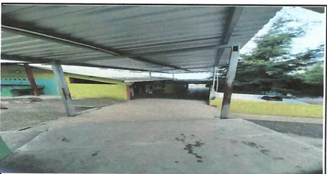
Foto 9: Corredor trasero, previsto para colocar iluminación
