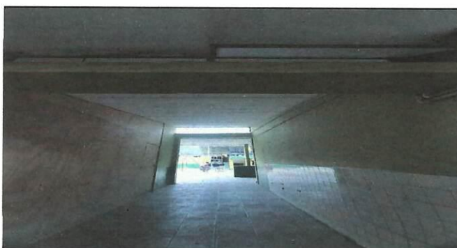
Foto 8: pasillo frontal, previsto a colocar iluminación.
