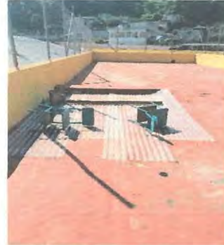
Foto 2: para proteger de filtraciones se ha colocado este material para evitar filtraciones mas fuertes
