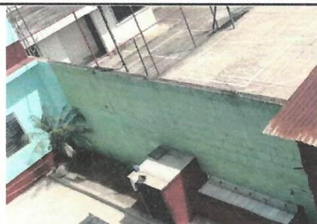
Foto 2: SUSTITUCIÓN CERCO O MURO PERIMETRAL
