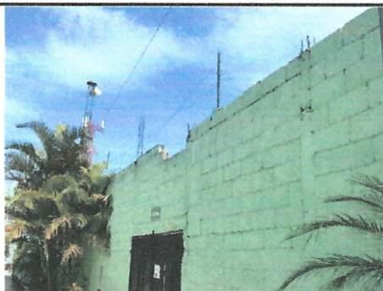
Foto 1: SUSTITUCIÓN CERCO O MURO PERIMETRAL
