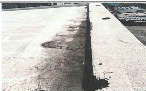
Foto 5: CANALES Y BAJADAS DE AGUA PLUVIAL
