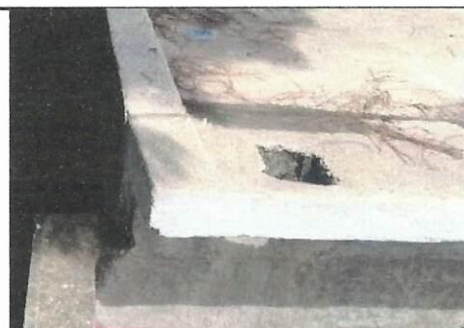
Foto 4: CANALES Y BAJADAS DE AGUA PLUVIAL
