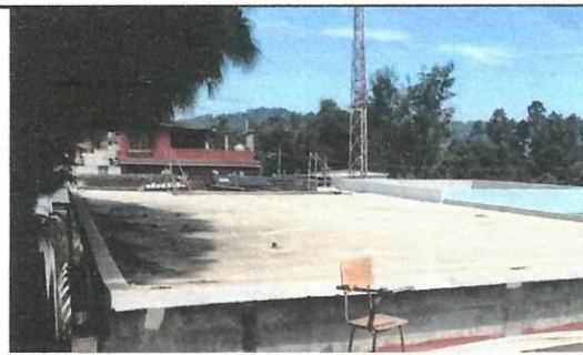
Foto 6: CANALES Y BAJADAS DE AGUA PLUVIAL
