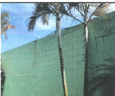
Foto 3: SUSTITUCIÓN CERCO O MURO PERIMETRAL
