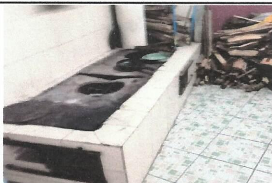
Foto 3: Reparación de azulejo en muebles de cocina
