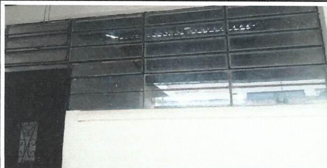
Foto1: Sustitución de estructura de metal de ventana por PVC
