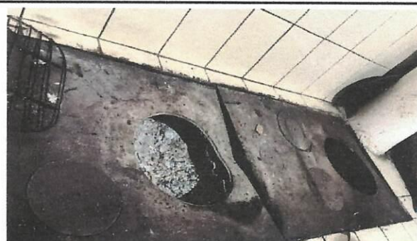
Foto 2: Sustitución de plancha de metal de 3 homillas
