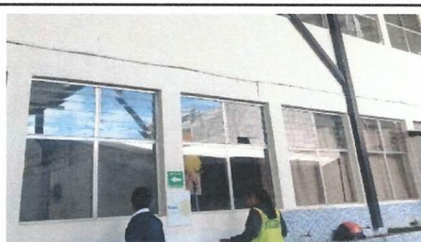
Foto 4: Sustitución de estructura de metal de ventana por PVC
