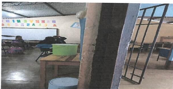
Reemplazo de puerta.
