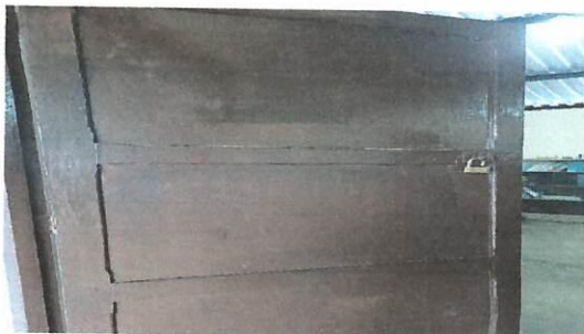
Reemplazo de puerta.
