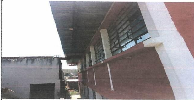
Restauración de ventana existente y agregado de ventana corrediza.
