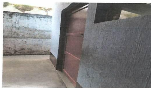
Reemplazo de puerta.
