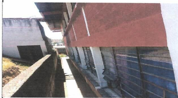
RESTAURACIÓN DE VENTANAS EXISTENTES Y AGREGADO DE VENTANAS CORREDIZAS.
