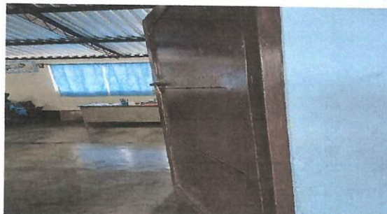
Reemplazo de puerta.
