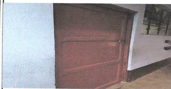
Reemplazo de puerta.
