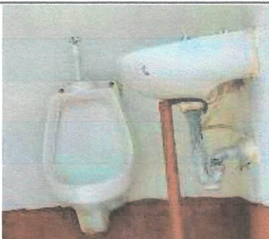
Foto 3: Sustrucción de mingitorio / Sustrucción de lavamanos
