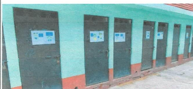
Foto 5: Pintura a puertas de servicios sanitarios
