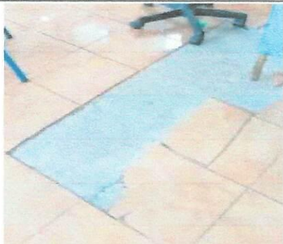
Foto 1: Sustrucción de piso cerámico
