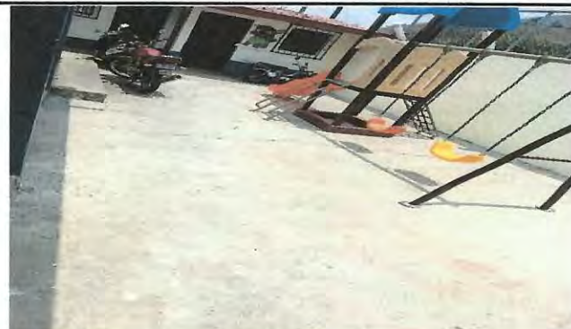
Foto 20: suministro e instalación de piso de concreto en el patio de juegos, 60 metros.
