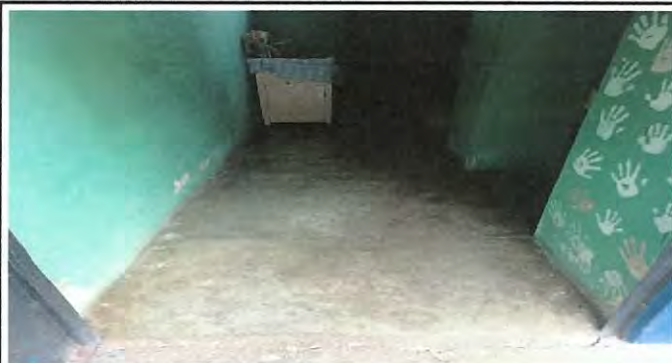
Foto 7: Reparación de paredes,+ demolición de mingitorio en mal estado+ instalación de piso cerámico en los dos sanitarios. Aplicación de pintura en interior+ aplicación de cernido gris+ acabado+ suministro e instalación
