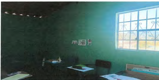
Foto 17: fundición de zapata, armado y fundición de columna, armado de columna+vano de ventana+suministro e instalación de ventana de hierro, corrediza, incluye malla mosquitera.
