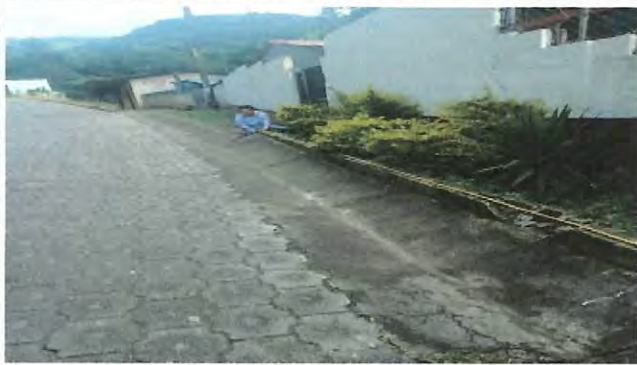
Foto 13: excavación de area de banqueta, ensabientado en muro perimetral, suministro e instalación de naylon grueso, jardinzación por humedad.
