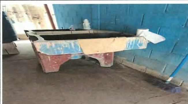
Foto 9: demolición de piso para instalación de pileta, e instalación de chorro+ aplicación de pintura en toda el área de sanitarios.
