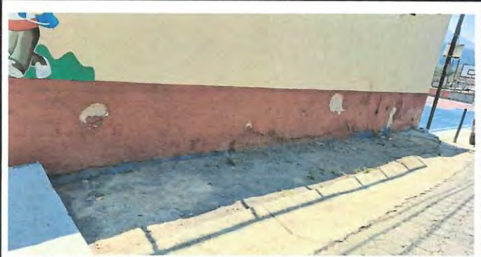
Foto 14: mejoramiento de pavimento, para parqueo, colocación de bordillo, demarcación de parqueo.
