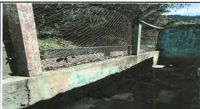
Foto 4: Mantenimiento y sustitución de malla existente en mal estado + limpieza de muros.
