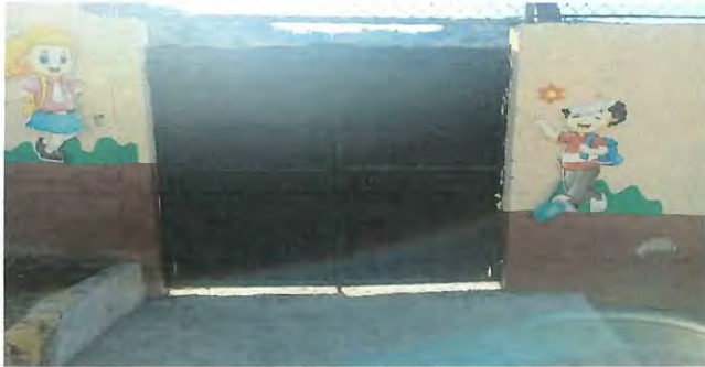
Foto 15: Suministro de Portón de acceso principal+ reparación de las columnas del portón.
