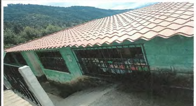
Foto 10: suministro e instalación de canal en dos salones continuos, humedad en paredes de salones por no tener canal+ limpieza de muros, bajadas de agua pluvial.
