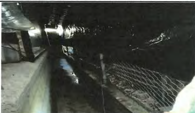
Foto 1: Mantenimiento y sustitución de malla existente en mal estado, en muro perimetral existente.
