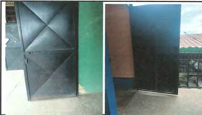
Foto 8: Reparación y pintura en cuatro puertas de baños, dos externas y dos internas.
