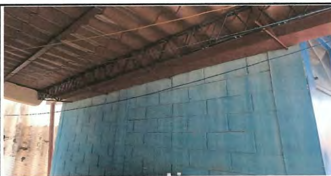
Foto 11. instalación de canal metalico, con corrección adecuada pendiente.
