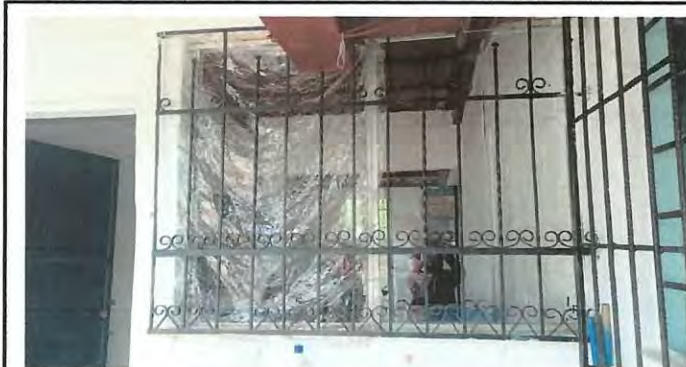
Foto 19: Suministro e instalación de ventana pvc,color blanco, con malla mosquitera en el area de la cocina.
