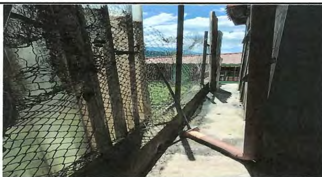
Foto 3: Mantenimiento y sustitución de malla existente en mal estado en muro perimetral existente.
