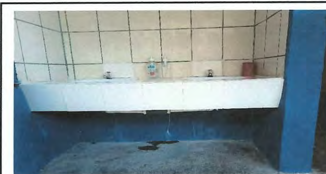
Foto 12. Reparación de fuga de lavamanos
