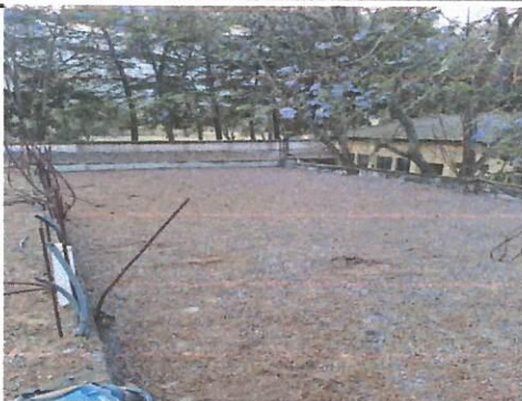
Foto 1: Limpieza de Losa Parte de Atras
