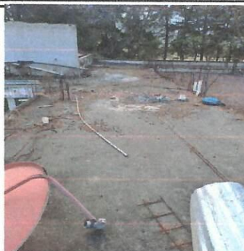
Foto 2: Limpieza de Losa fondo izquierdo
