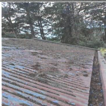
Foto 9: Retiro de desechos organicos y laminas en mal estado
