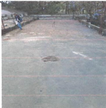
Foto 7: Seguimiento de Impermeabilizante
