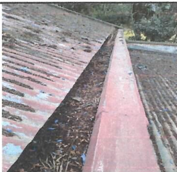
Foto 11: Retiro de desechos organicos y laminas en mal estado
