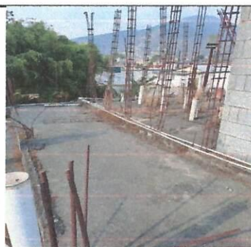
Foto 6: Seguimiento Impermeabilización de Terreza
