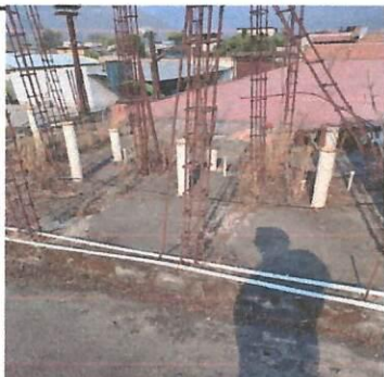
Foto 5: Seguimiento Impermeabilización de Terreza
