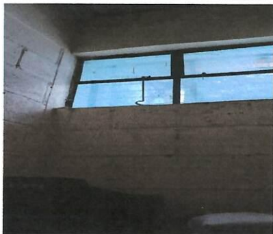
Foto 7: Estas son las ventanas superiores
