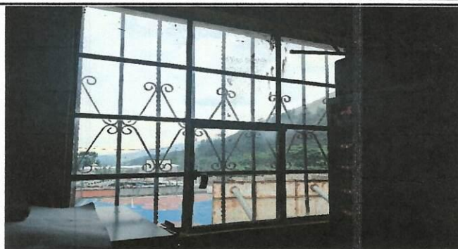
Foto 8. Suministro e instalacion de ventanas pvc 1.20x 0.99
