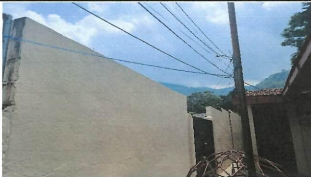
Foto 15. Suministro e instalación de muro de malla
