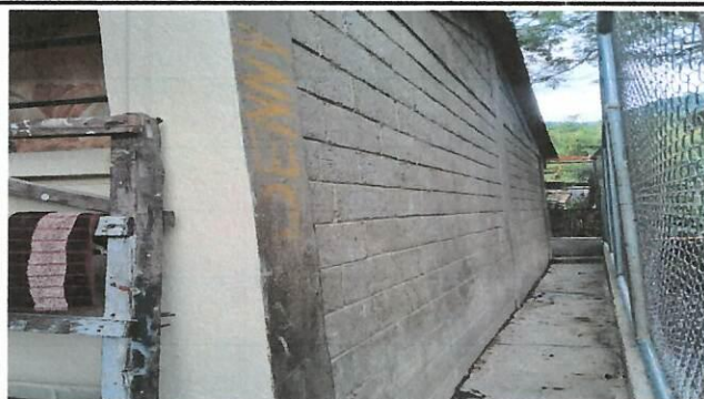
Foto 4 : Abertura de ventana de 1.60 x 1.20 e instalación y suministro e instalación de ventanas pvc+balcón
