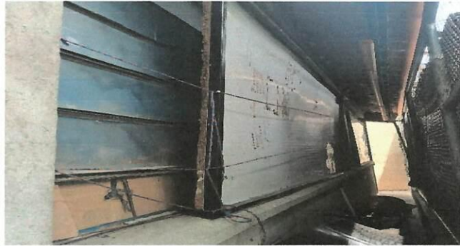
Foto 13: Sello de ventanas de 3.50x 1.00, suministro e instalación de de ventanas pvc en su lugar.
