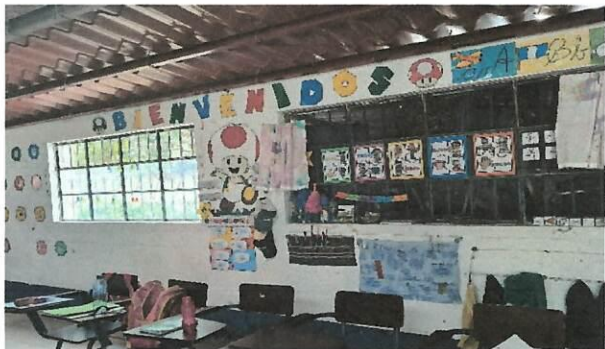
Foto 7. Suministro e instalacion de ventanas pvc 2.00 x 0.99
