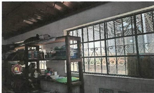
Foto 9. Suministro e instalacion de ventanas pvc 2.00 x 0.99
