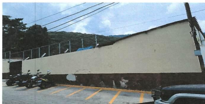
Foto 20: Suministro y aplicación de cernido para emparejar+aplicación de pintura
