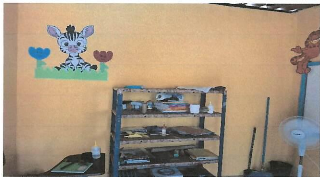
Foto 1 : Abertura de ventana de 1.60 x 1.20 en salon de clases de primaria e instalación y suministro de ventana pvc+balcón.
