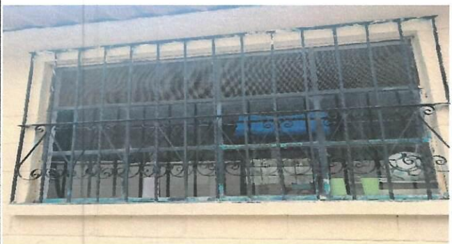
Foto 16: limpieza y pintura de balcones de 20 ventanas
