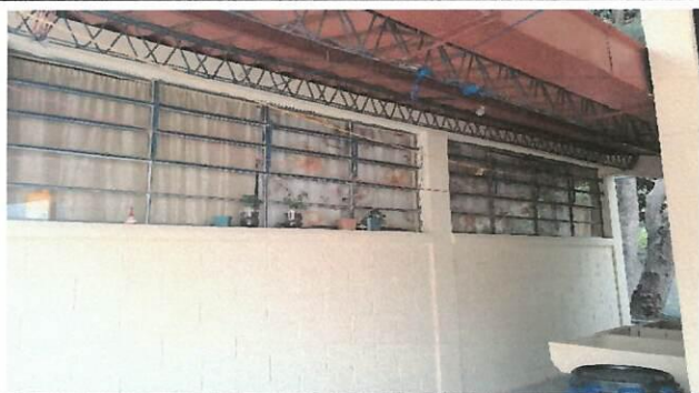
Foto 11. Suministro e instalacion de ventanas pvc 3.47 x 0.50
