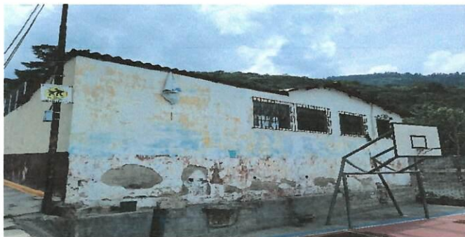
Foto 19: Suministro y aplicación de cernido para emparejar+aplicación de pintura
