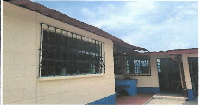
Foto 14: suministro en instalación de canal 15x25x20
