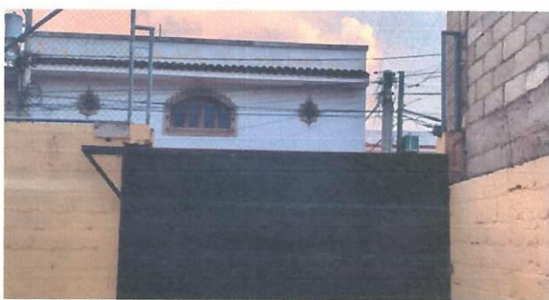
Foto 2: Suministros e instalación de techo de dos aguas en portón de entrada principal.
