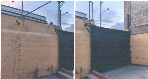
Foto 3: Suministros y mantenimiento de portón de metal de la entrada principal.
