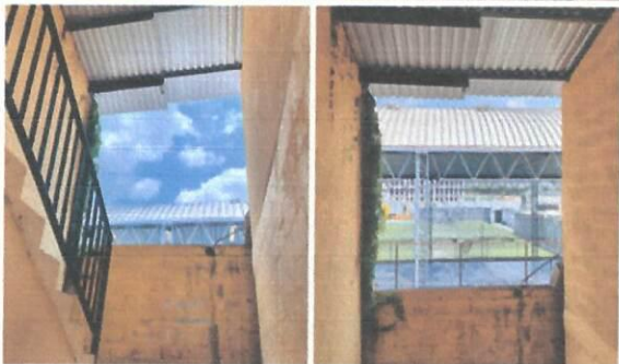
Foto 10: Suministros y colocación de malla en pared que da para la calle principal.
