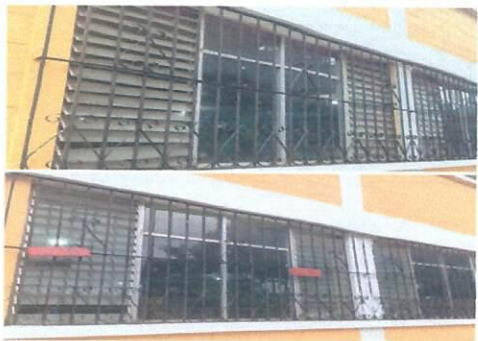
Foto 7: Suministros y mantenimiento de balcones, limpieza y cambio de algunos vidrios quebrados en balcones del modulo del primer nivel.
