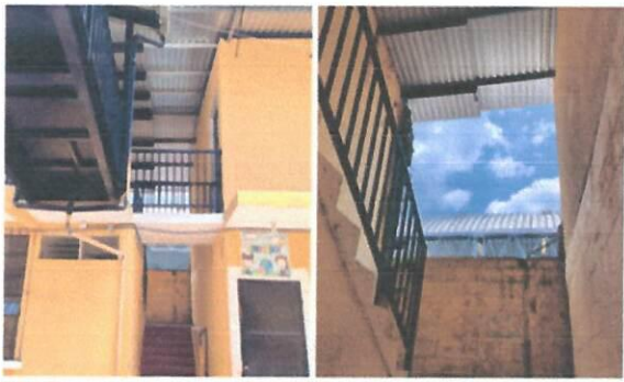
Foto 9: Suministros y colocación de malla en pared que da para la calle principal.
