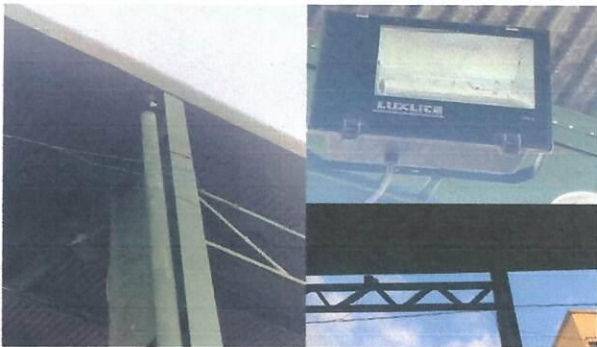
Foto 12: Suministros y mantenimiento de tendido eléctrico y cambio y compra de lámparas en el área de cancha principal.
