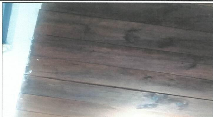
Foto 1: SUSTITUCIÓN DE PIEZAS DE CIELO FALSO MACHIMBRE
