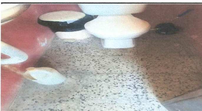
Foto 4: REPARACIÓN EN BAÑO PARA MAESTROS Y MANTENIMIENTO DE LA INFRAESTRUCTURA
