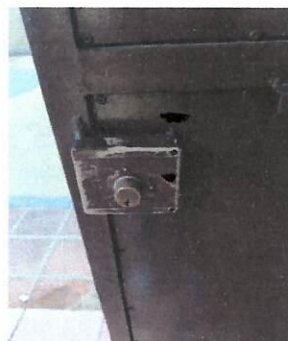
Foto 8: SUMINISTRO Y CAMBIO DE PASADOR DE PUERTA DE METAL (SALÓN DE CUARTO BACH).
