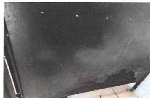
Foto 10: SUMINISTRO Y CAMBIO DE MAMAPARA DE METAL EN SERVIVCIO SANITARIO DE HOMBRES .INCLUYE APLICACIÓN DE PINTURA ANTICORROSIVA CAFÉ QUEMADO
