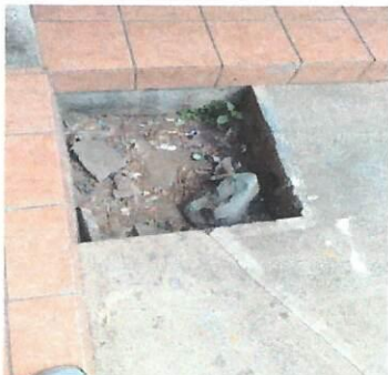
Foto1: SUMINISTRO E INSTALACIÓN DE REJAS DE METAL EN CAJAS PLUVIALES. PARA ASEGURAR ESTE ESPACIO
