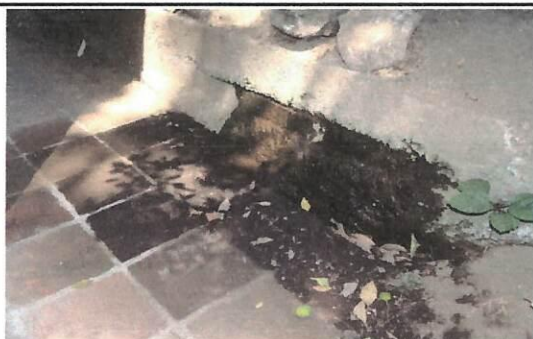
Foto 5: REPARACIÓN DE GRIETAS EN CISTERNA Y CAMBIO DE FLOTE
