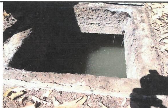
Foto 4: MANTENIMIENTO DE FOSA SÉPTICA (LIMPIEZA)
