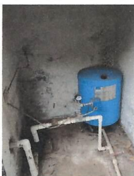
Foto 15: SUMINISTRO E INSTALACIÓN DE EQUIPO HIDRONEUMÁTICO NUEVO
