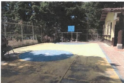
Foto 13: LIMPIEZA ,SUMINISTRO Y APLICACIÓN DE PINTURA ACRÍLICA CON ALTA RESISTENCIA A LA INTERPERIE EXPOSICIÓN SOLAR Y ABRASIÓN PARA CANCHA DEPORTIVA
