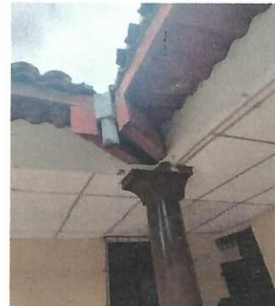
Foto 2: SUMINISTRO E INSTALACIÓN DE CANAL METÁLICO 2 BAJADAS PLUVIALES
