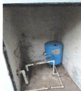
Foto 6: SUMINISTRO Y APLICACIÓN DE PINTURA LATEX LAVABLE PARA EXTERIOR EN CUARTO DE MAQUINAS. PARA MANTENIMIENTO DE CASETA DE BOMBAS
