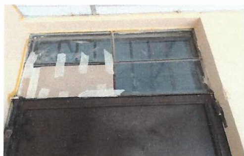
Foto 9: SUMINISTRO E INSTALACIÓN DE VIDIROS DE PUERTAS DE SALÓN DE CLASES (6)
