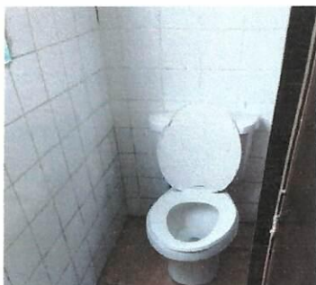
Foto 11: REPAPARACIÓN DE INODODRO TAPADO
