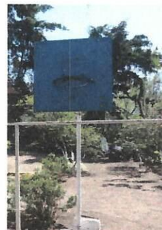
Foto 14: SUMINISTRO E INSTALACIÓN DE TABLEROS Y CANASTAS DE METAL CON MEDIDAS OFICIALES DE BALONCESTO .(INCLUYE MODIFICACIÓN DE POSTES EXISTENTES Y APLICACIÓN DE
