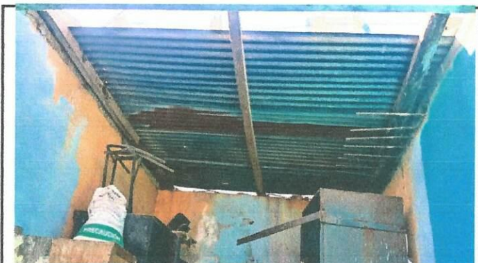
Sustitución de lámina y madera por lámina nueva y bigas de metal.
