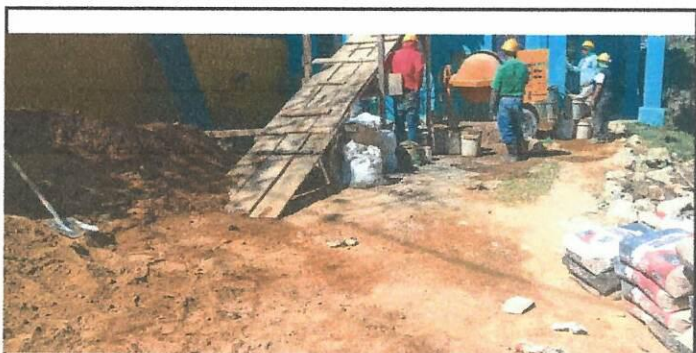
Mejoramiento de suelo con adoquín.
