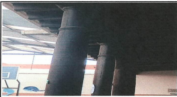
Foto 9: Mantenimiento de la madera de los parales
