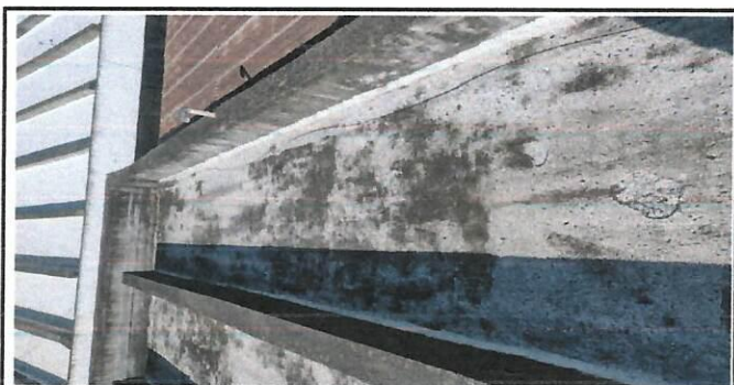
ÁREA DAÑADA EN LOSA, APLICACIÓN DE IMRERMEABILIZANTE INTEGRAL Y REPARACIÓN DE DAÑO POR EDAD DE LOSA
