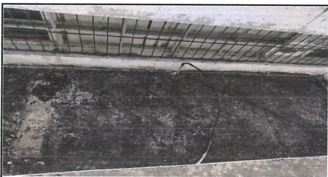
ÁREA DAÑADA EN LOSA, APLICACIÓN DE IMRERMEABILIZANTE INTEGRAL Y REPARACIÓN DE DAÑO POR EDAD DE LOSA
