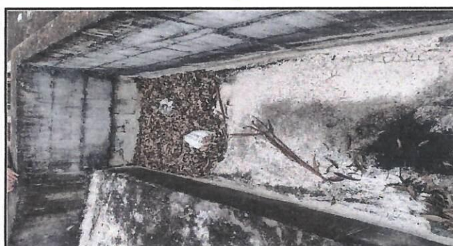
Foto 5: área dañada en loza, aplicación de impermeabilizante
